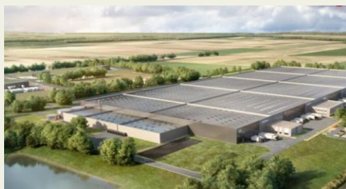
Sur un entrepôt de 118 000 m 2 , le groupe ESR a fait de sa plateforme un véritable hub énergétique — 61 000 m 2 de toiture solaire, 8 000 m 2 d'ombrières photovoltaïques sur le parking, des bornes de recharge et deux batteries de stockage. L'ensemble produit près de 13 GWh par an, soit la consommation de 3 500 foyers.
