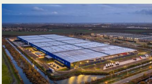
Entrepôt Omega de Douges (Pas-de-Calais) , loué par PepsiCo. Ses 136 000 m 2 de toiture accueillent la plus grande centrale solaire d'Europe d'un seul tenant — 18 MWc, environ 38 000 panneaux.
